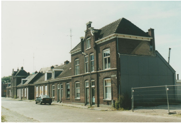
Woningen aan de Bergpoortstraat in Deventer voor aanpassing
